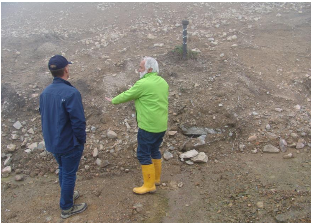
Debattiert wurde die „Zerstörung“ der Quelfassung, erkennbar am Entlüftungsrohr.
