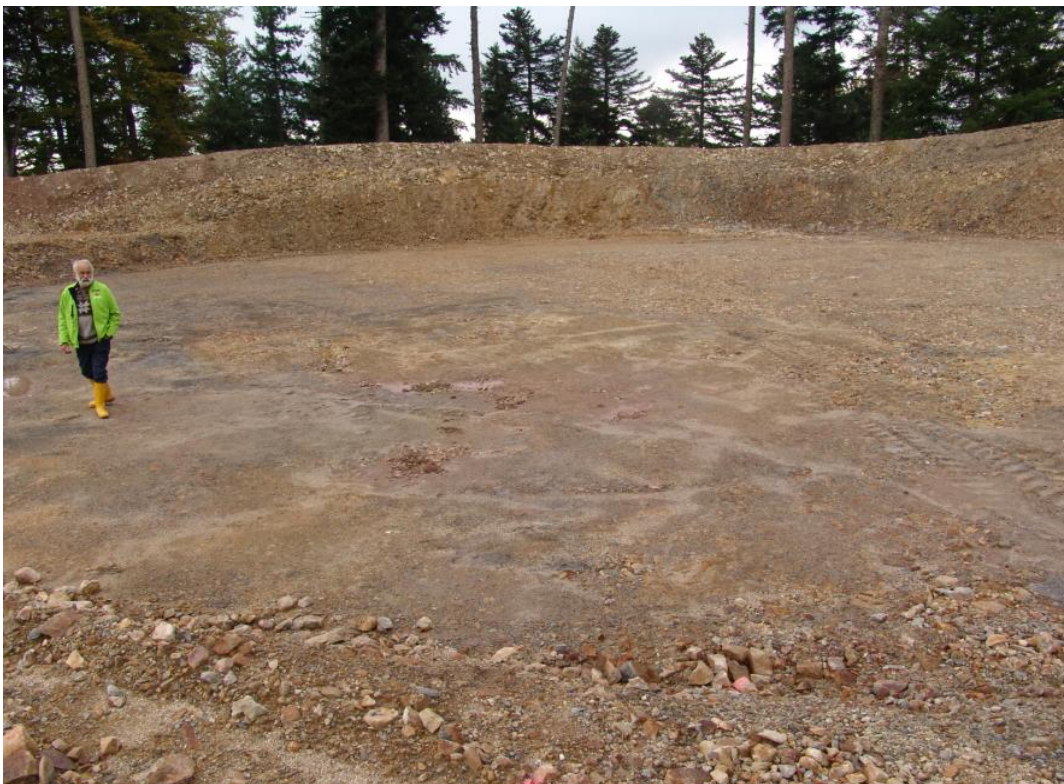
Die Dimensionen der Aushubgruben für die kreisrunden Fundamente der Windkraftanlagen werden aus diesem Foto ersichtlich. 30 Meter beträgt der Durchmesser. Der Vermutung, dass der teilweise wassergesättigte und „schwabbelige“ Untergrund in dieser Baugrube die
